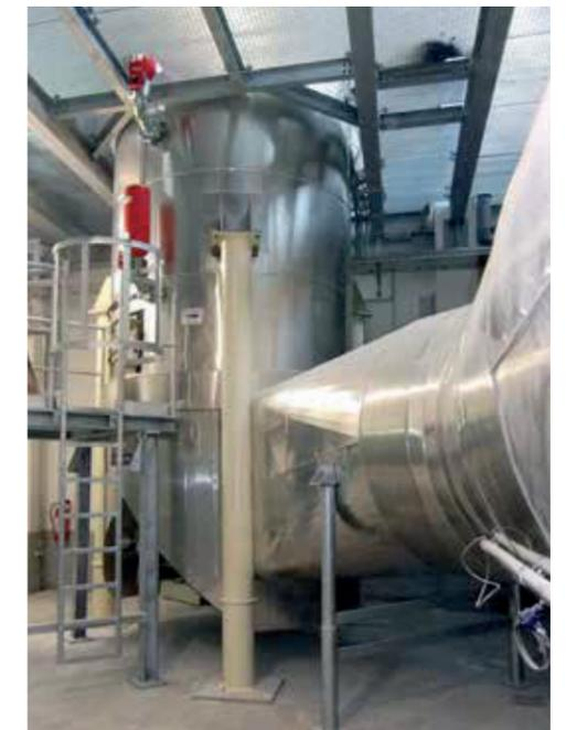
Trocknerunterteil mit Trocknungslufteintritt
