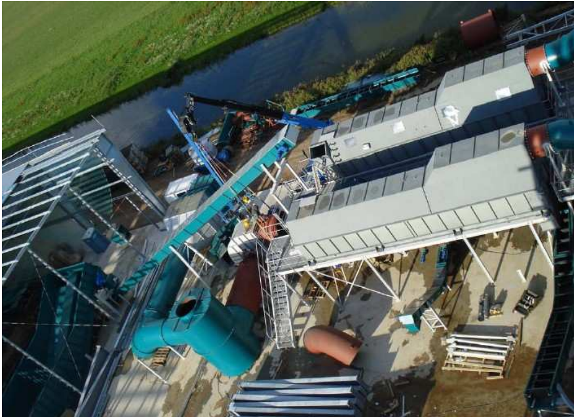
Bild 4: Baustelle der Fa. Topell Energy mit zwei großen Allgaier-Wälzbett-Trocknern
