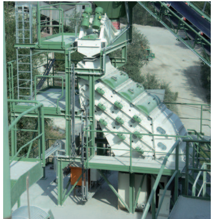
NC 2024 – Siebung von Kalkstein
