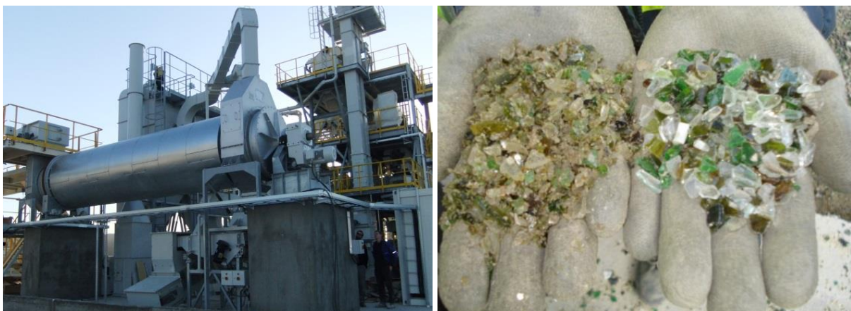
Abb. 1a und 1b: Trocknungsanlage für Altglas sowie Produkt vor und nach der Trocknung
