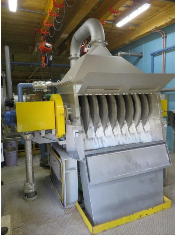
Abb. 3: CD Dryer zur Entsorgung eines salzhaltigen Chemieabwassers und zur Gewinnung des in der Flüssigkeit enthaltenen Wertstoffes
