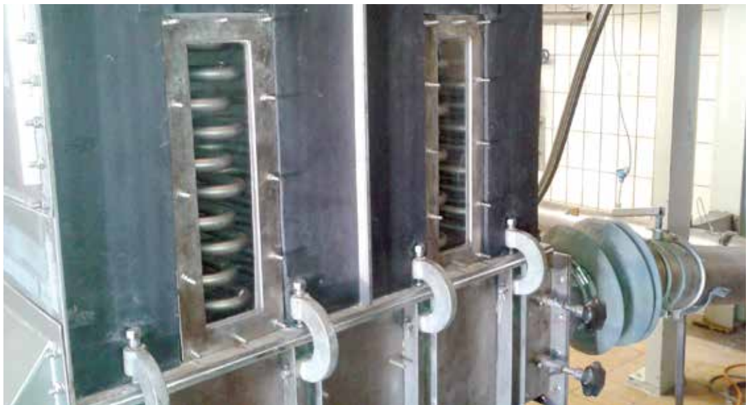
Installation expérimentale au centre technique Allgaier
