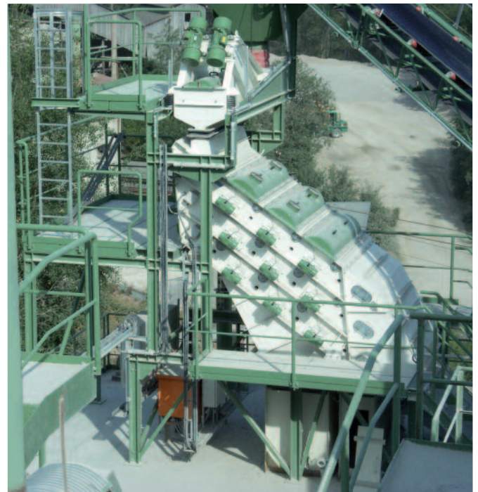
NC 2024 – Criblage de calcaire brut
