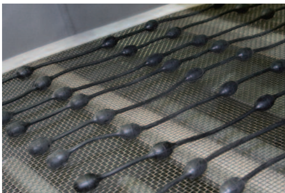
Nettoyage mécanique des cribles
