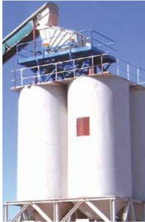
Installation de tamisage dans l'industrie des mines et carrières
